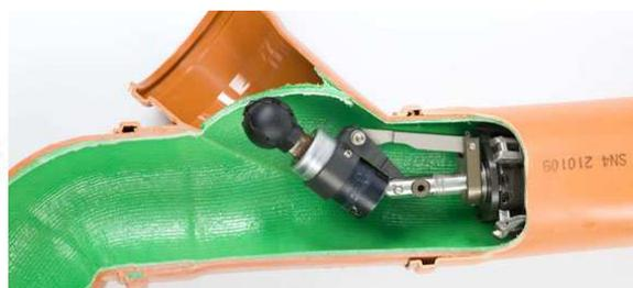
Ouverture d'un branchement sur un liner
